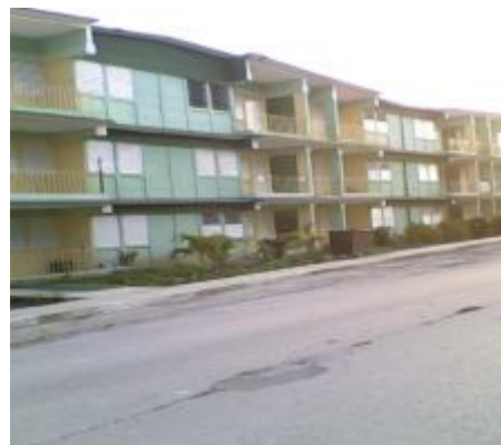
De edificios multifamiliares
