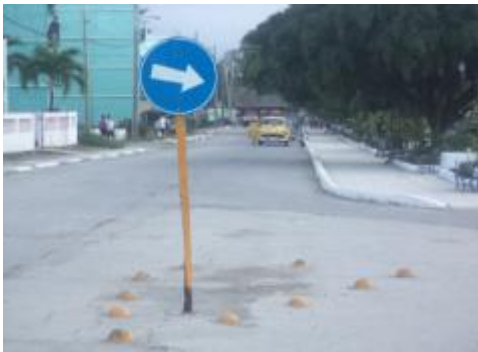
Señalización del tránsito
