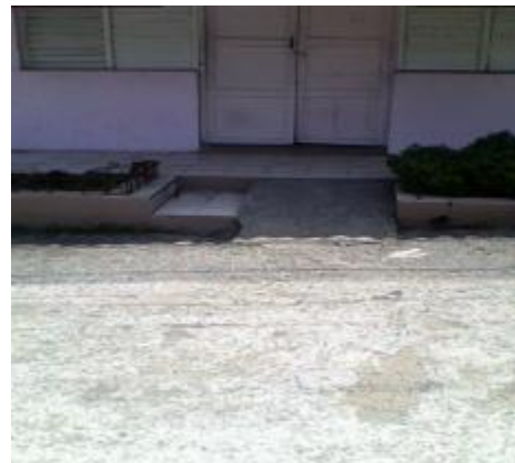
Construcción de rampas
