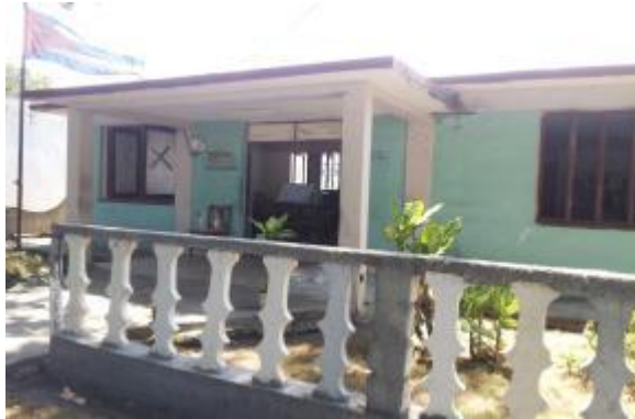
Cercado en instalación
