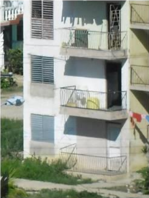
Balcones en edificios multifamiliares
