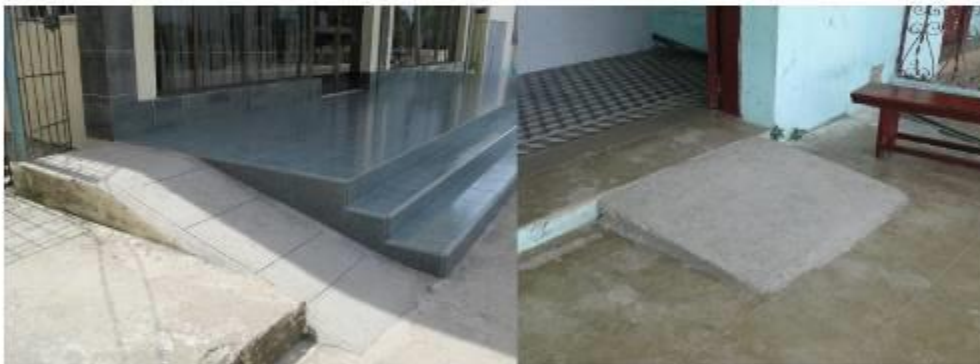
Construcción de Rampas
